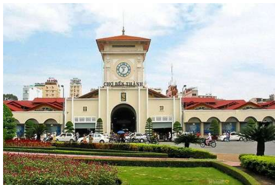
Hình 1. Chợ Bến Thành. Nguồn: Nguyễn Công Trí. Năm 2025
