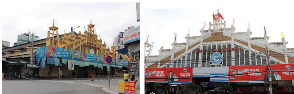
Hình 6. Hệ mái chợ Tân Định. Nguồn: Nguyễn Công Trí. Năm 2025
